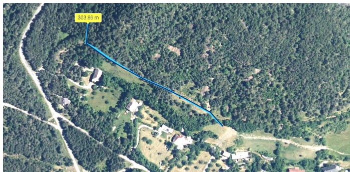
Vue aérienne du tronçon renouvelé en 2024
